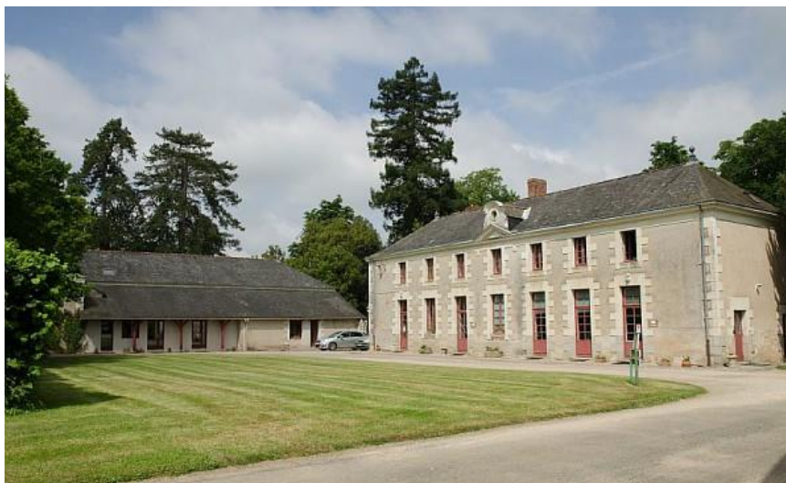
Bâtiment principal de la station expérimentale de La Jaillière
